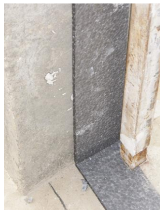
Figura 8. Colocación de banda de EEPS en perímetro de fábrica
