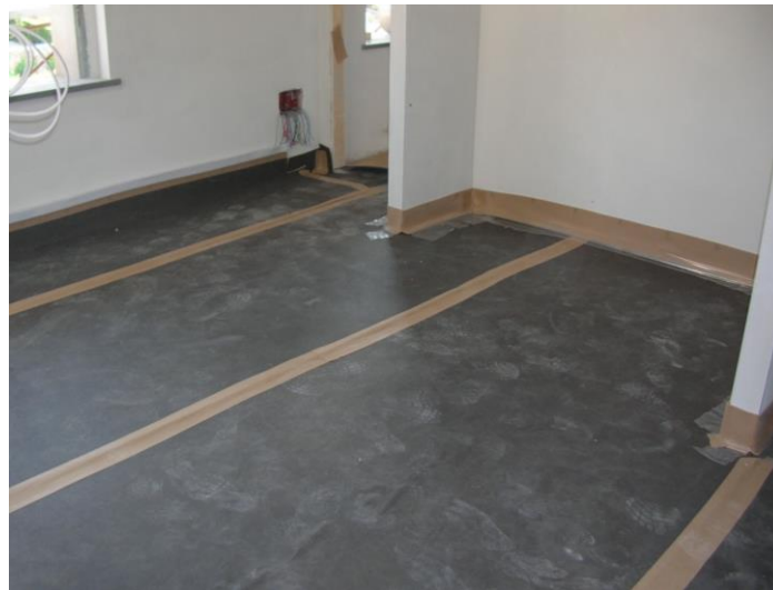
Figura 10. Detalle de instalación de lámina de PE reticulado en suelo flotante
