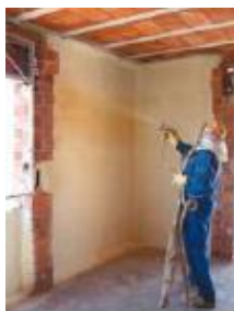
Figura 11. Detalle de instalación de espuma de poliuretano de celda cerrada aplicado in-situ
