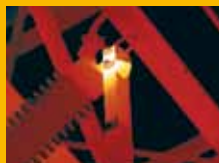
Conexión mal asegurada
