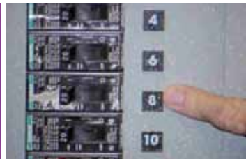
El punto caliente indica un cortocircuito que podría provocar un incendio.
