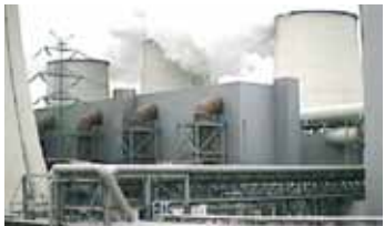
Inspección de aislamiento
