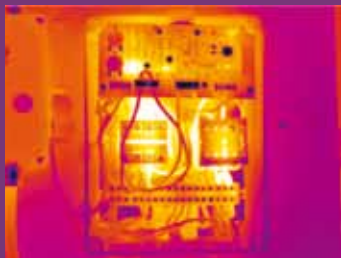
Termografía: 640 x 480 píxeles
