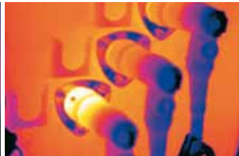
Conexión recalentada
